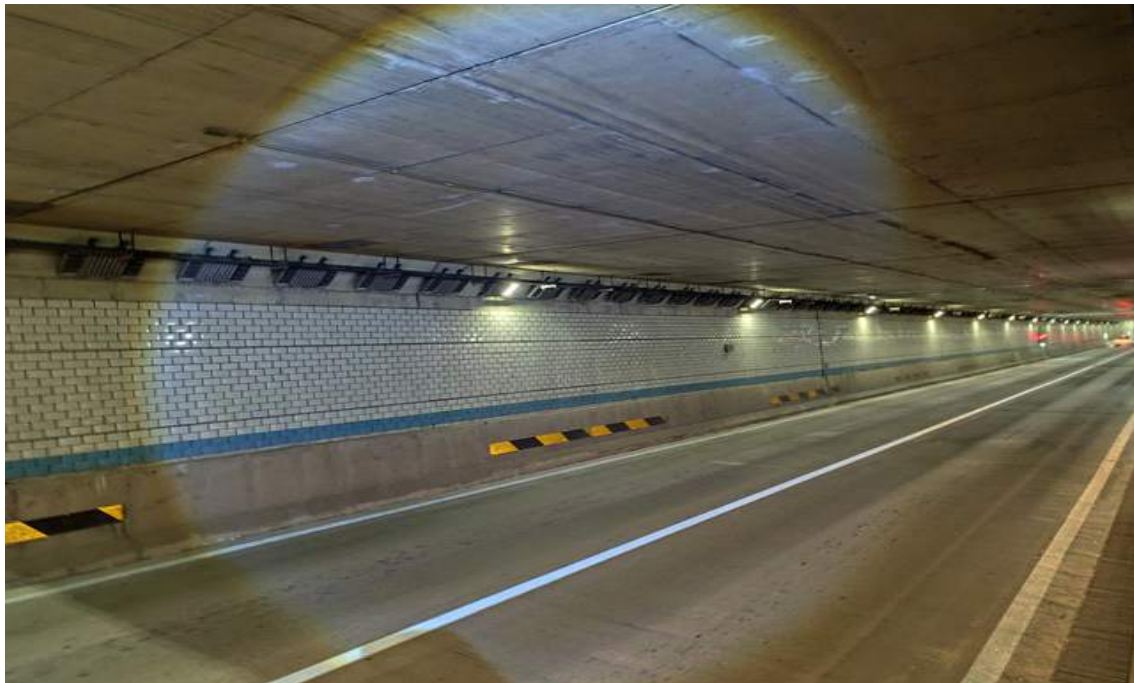
BOX구간 벽체 전경
