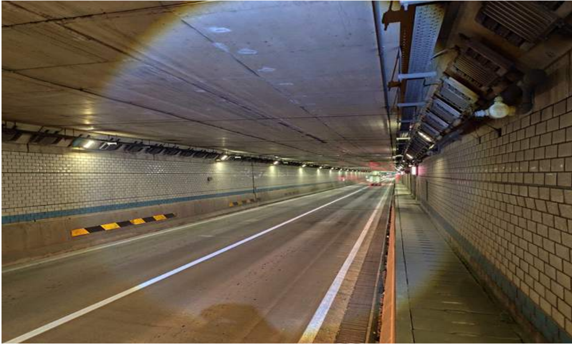
BOX구간 내부 전경
