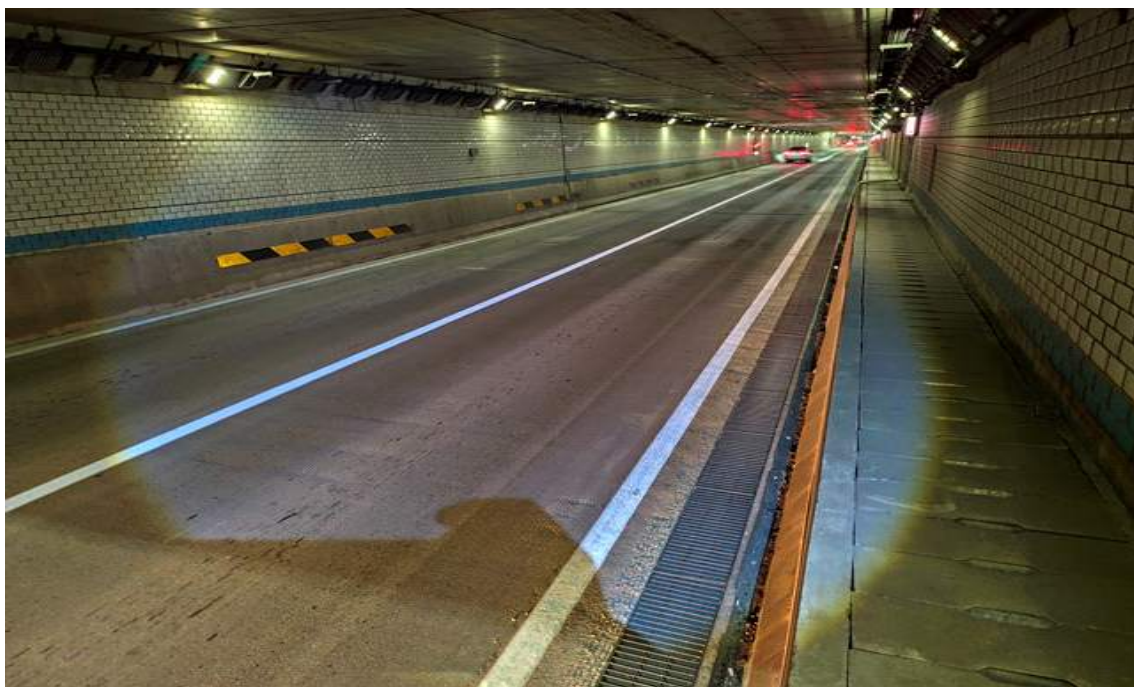
BOX구간 포장 전경
